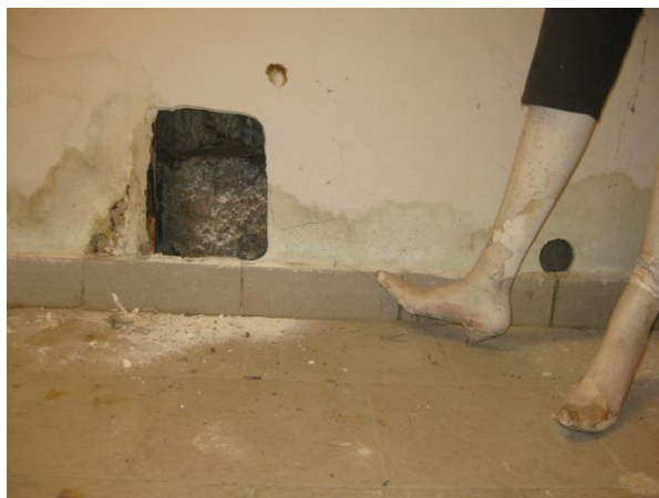
Obr. 14: Sonda provedená ve spáře kamenného zdiva za sádrokartonovou předstěnou
