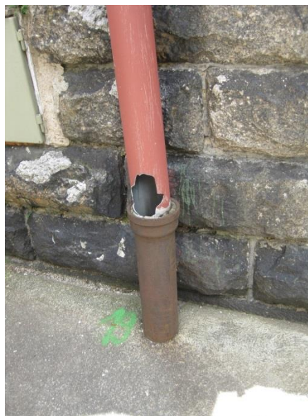
Obr. 8: Současný stav některého ze svislých dešťových potrubí
