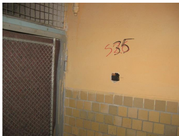
Obr. 22: Provedená sonda S35 do předstěny v chodbě
