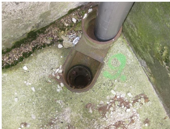
Obr. 6: Pohled na současný stav napojení dešťového potrubí na litinový gajgr
