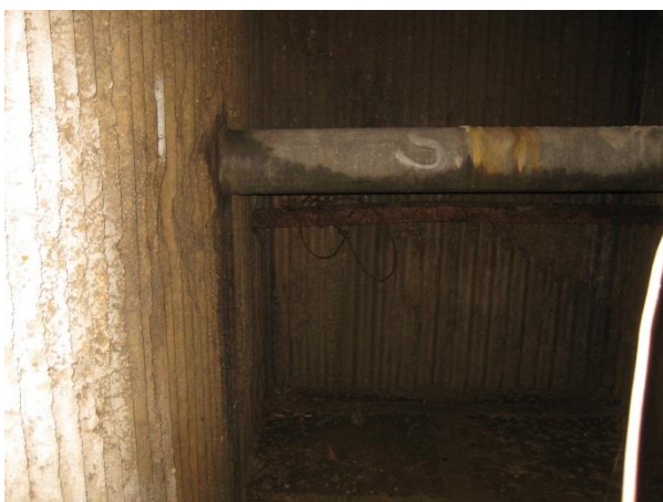
Obr. 15: Prostor s prosakující vodou přístupný ze suterénní učebny nacházející se pod parkovištěm před budovou
