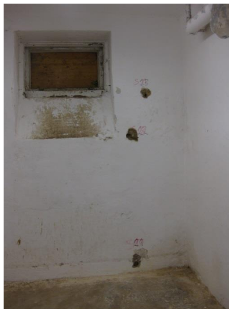
Obr. 20: Provedené sondy S21, S22, S23 po výšce obvodového zdiva
