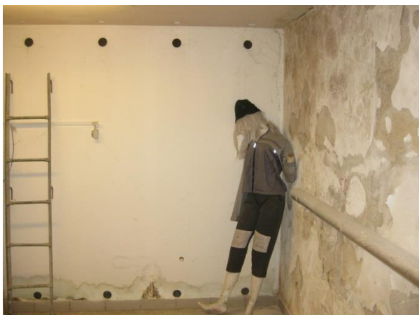
Obr. 13: Sádrokartonová předstěna a vlhkost-ní poruchy v kotelně
