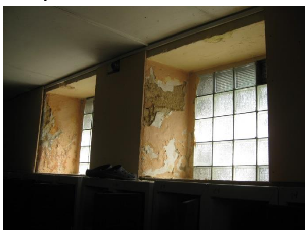
Obr. 11: Pohled na vlhkostní poruchy v ostění oken v šatnách v levém křídle
