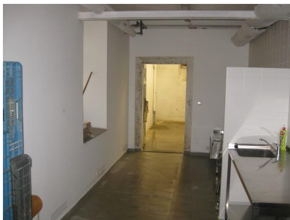
Obr. 18: Chodba s předstěnou ze sádrokartonové konstrukce
